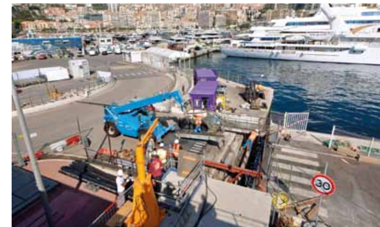
Les travaux de maintenance de la rotule de la digue seront menés jusqu'en octobre.
