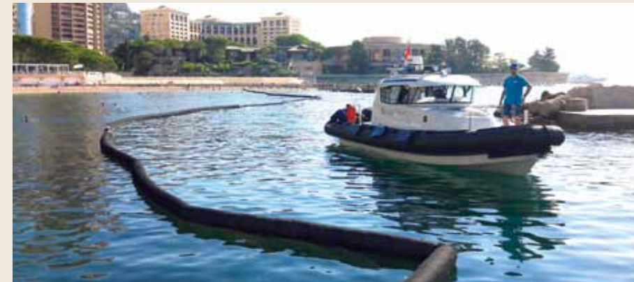
Déployés du T-central jusqu'à la rive, les 2 filets anti-méduses fournissent une protection efficace sur les côtés est et ouest de la plage du Larvotto. Ici, des agents de la DAM procèdent à une inspection du dispositif.
