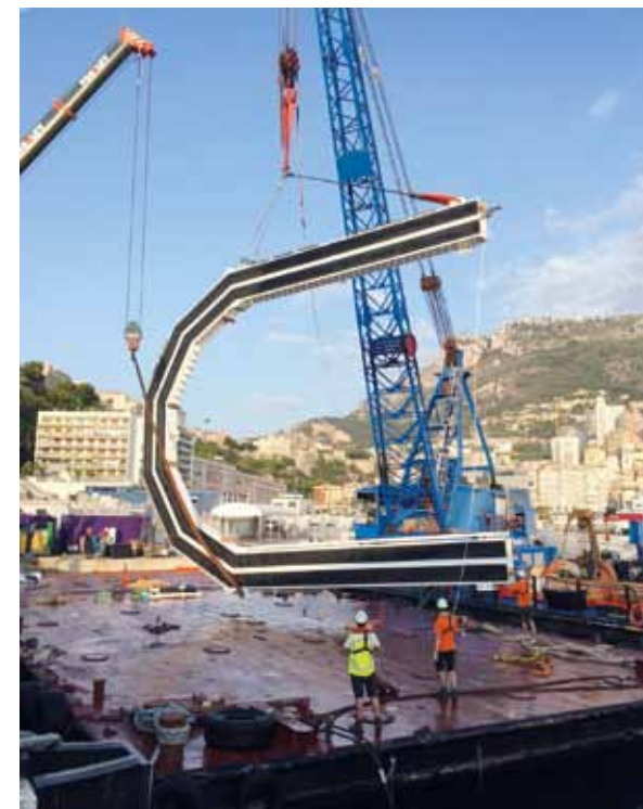
La mise en place du batardeau, qui affiche quelque 45 tonnes, a notamment requis l'utilisation d'une grue embarquée sur une barge flottante.
